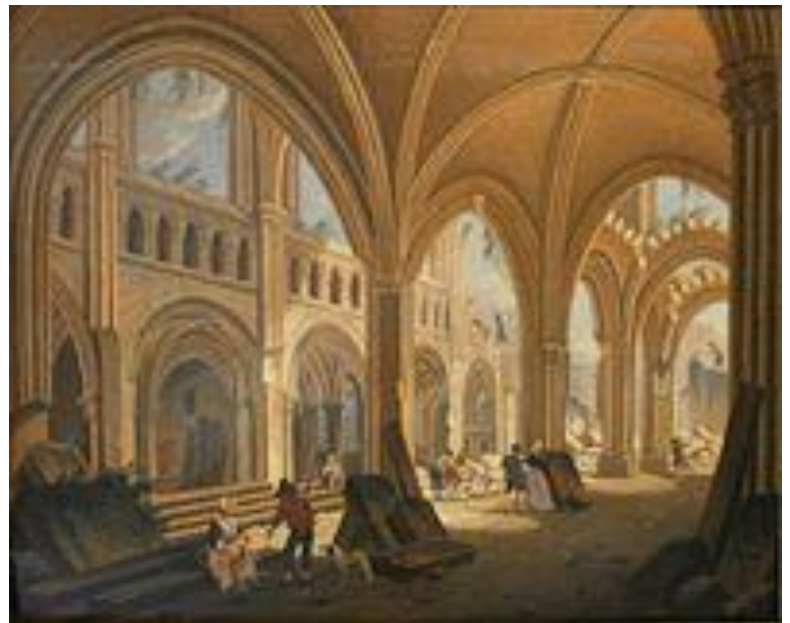
Démolition de l'église Saint-Jean-en-Grève, intérieur, par Pierre-Antoine Demachy (vers 1800, Musée Carnavalet).
