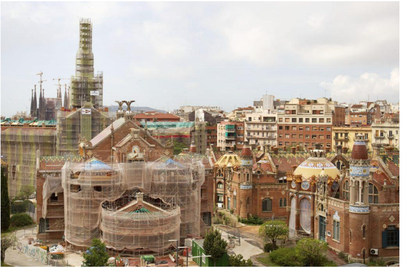
El Recinto Modernista en plena rehabilitación, 2011
